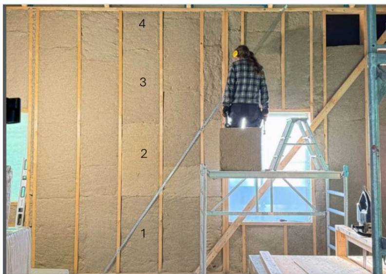
Izoliacinės plokštės (1–4), sumontuotos viena virš kitos tarp statramsčių.
